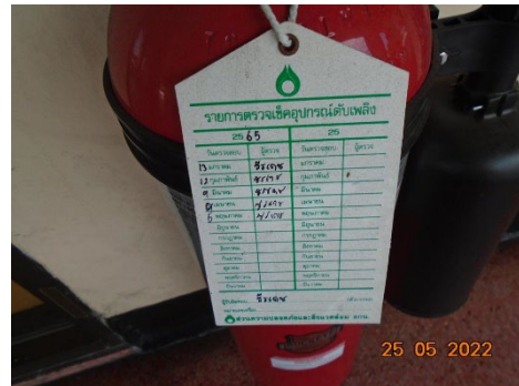
ภาพที่ 2-15 ป้ายแสดงการตรวจสอบประสิทธิภาพของเครื่องดับเพลิง
