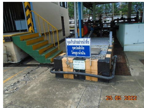
ภาพที่ 2-3 บ่อดักไขมันภายในพื้นที่โครงการ
